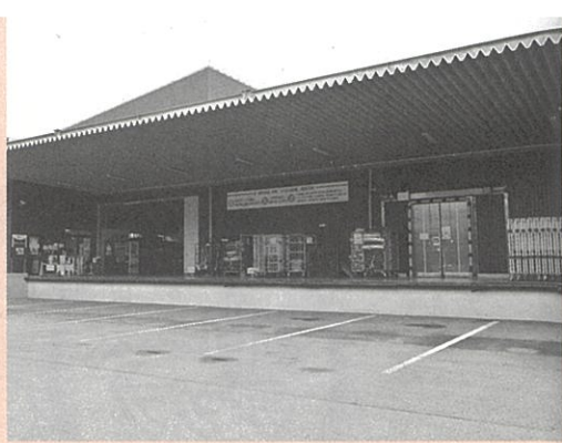
菊池ロジスティックセンター
